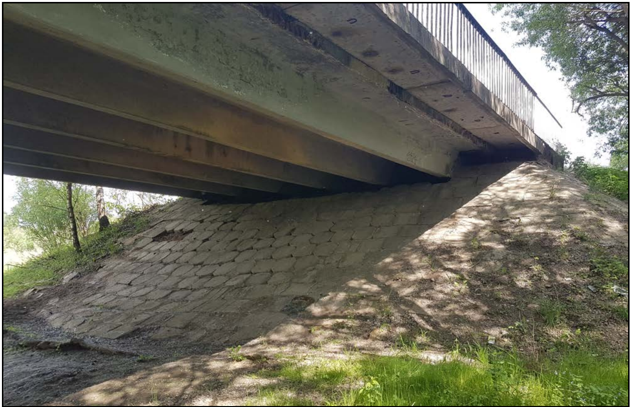
Рис. 5. Общий вид опоры 1.
