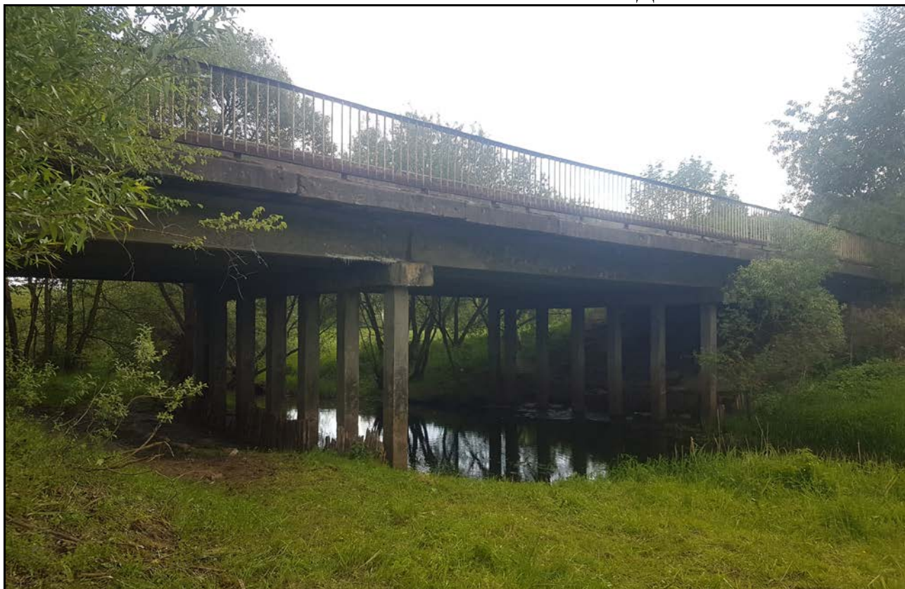
Рис.1. Общий вид моста (НП)
