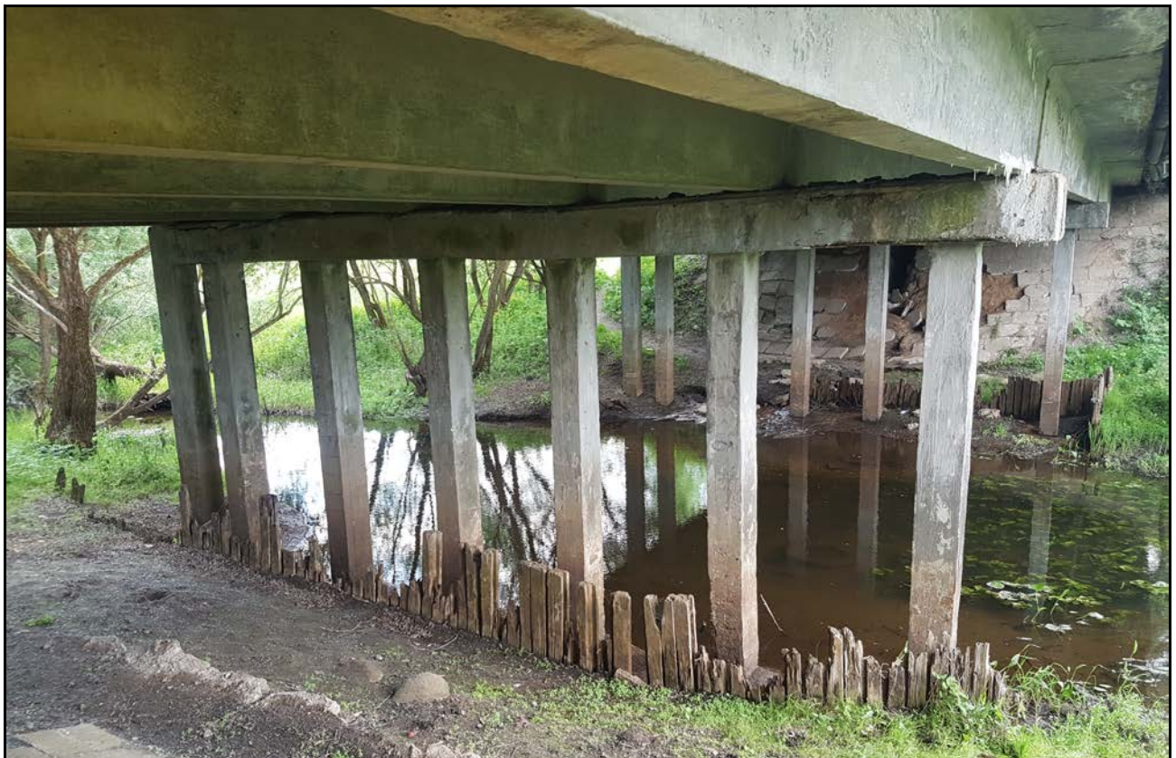
Рис. 6. Общий вид опоры 2.
