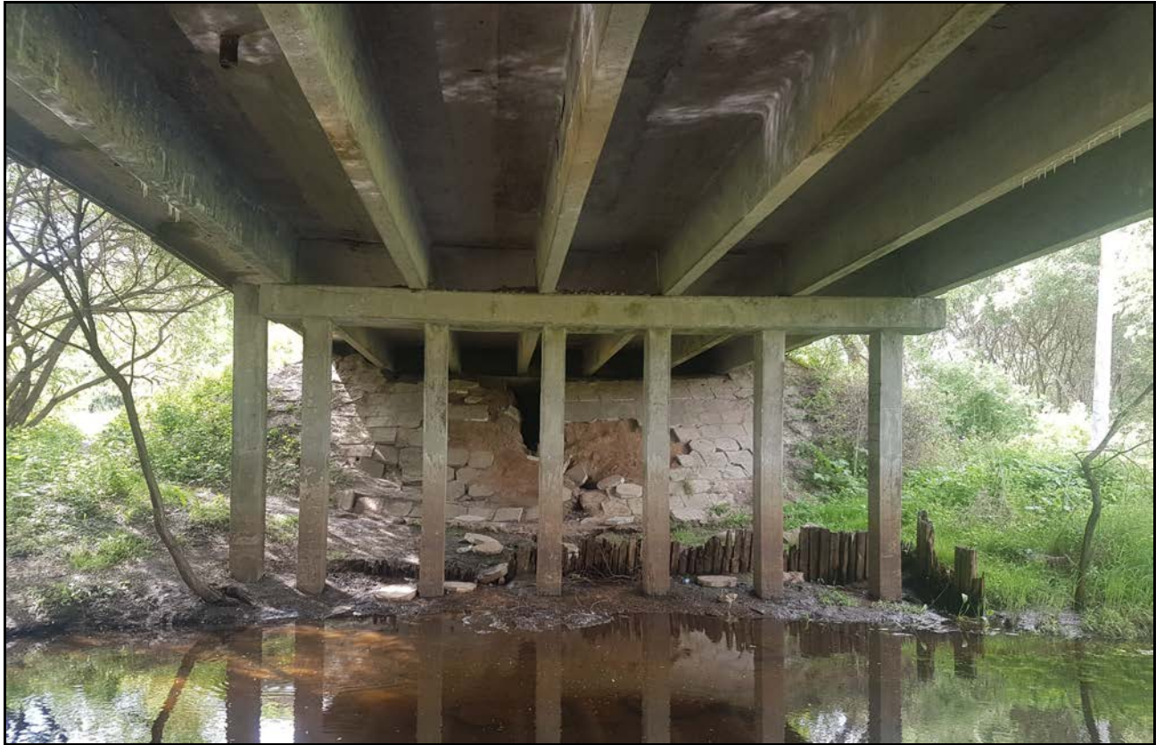
Рис. 7. Общий вид опоры 3.
